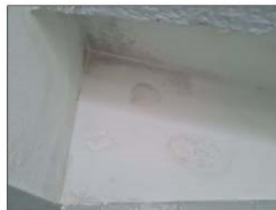
FOTO 96 - INFILTRAZIONE COPERTURA SOTTOTETTO HOTEL
