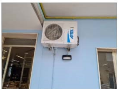
FOTO 90 - POMPA DI CALORE ESTERNA RAFFRESCAMENTO
