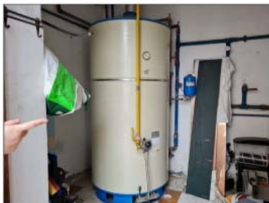
FOTO 85 - ACCUMULO ACQUA CALDA
